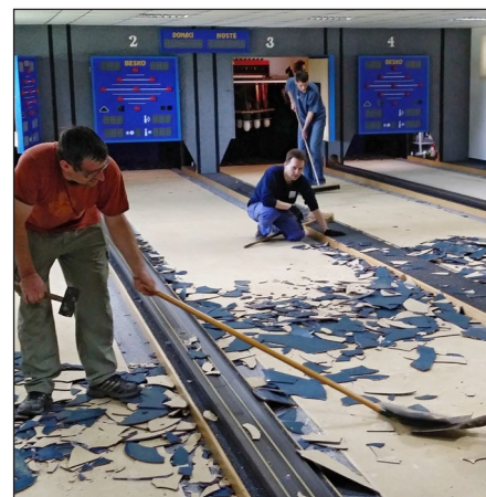
Práce na rekonstrukci drah v Rosicích
